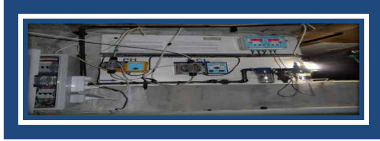
RESİM: HAVUZ KİMYASALI OTOMATİK DOZAJLAMA SİSTEMİ
